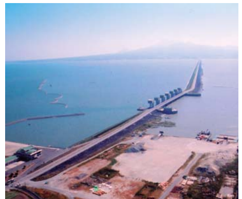
▲全長約7kmの潮受け堤防（右側が調整池）
