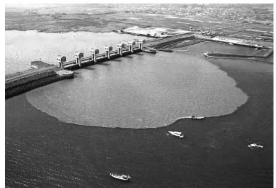
図7 北部水門からの排水の様子 海水との濁りの違いが一目瞭然
