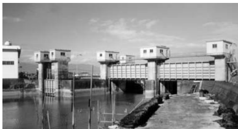
図5-2 佐賀県六角川の八田江防潮水門 高潮の時以外は水門が開放されている
